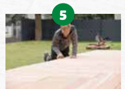
5 Terrasse ist fertig
